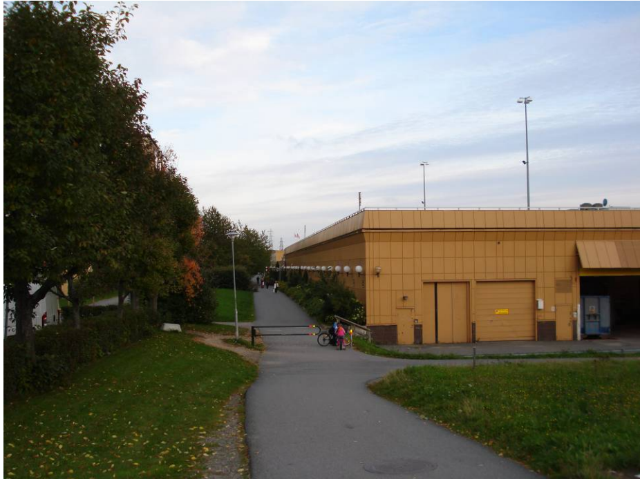
Bild 9: Vy från Borgvägen mot Hallunda centrum's baksida/norra fasad.
