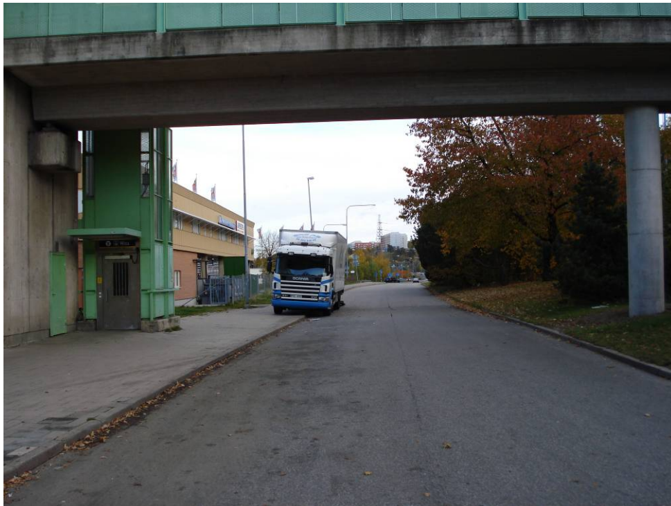
Bild 17. Del av Hallunda centrum fasad mot Hallundavägen. På bilden syns infartsvägen till bussterminalen samt hiss för gående från gångbron till t-banan.
